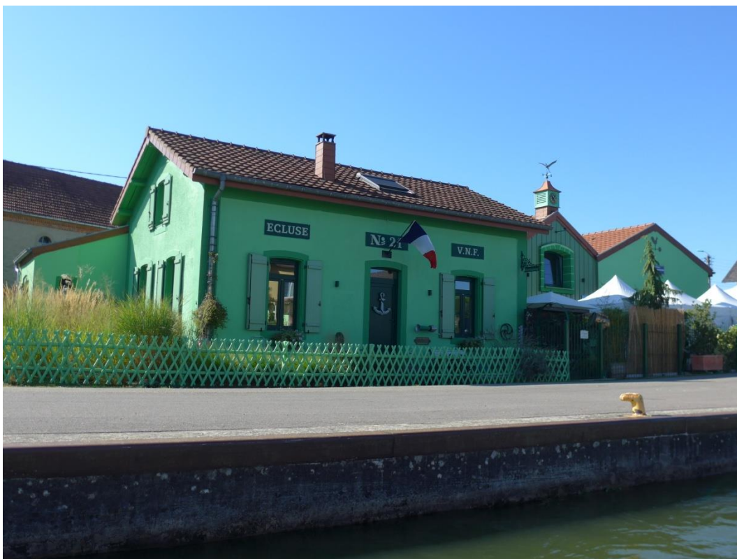
Bild 2: Ein Schleusenwärterhäuschen der alten Bauart
